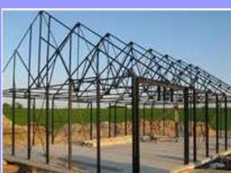
Comme l'ossature bois, la structure métallique offre une grande liberté de création sur le plan architectural. Toutefois limitée par les impératifs de la construction bioclimatique : pas question de multiplier les surfaces déperditives (parois froides), celles qui sont en contact avec l'extérieur de l'habitat.
