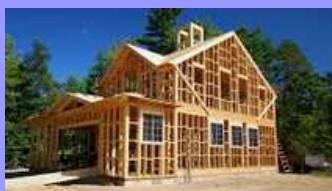
Il ne représente encore que 6 à 7 % du secteur de la construction, mais connaît aussi un bel engouement. On le trouve sous forme d'ossature, d'assemblage de madriers, de poteaux-poutres, ou encore en version mixte (bois/maçonnerie).
